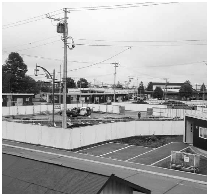
建替工事が進む若葉団地公営住宅
