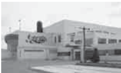
結露対策など改修が必要な『ふるさと館』
