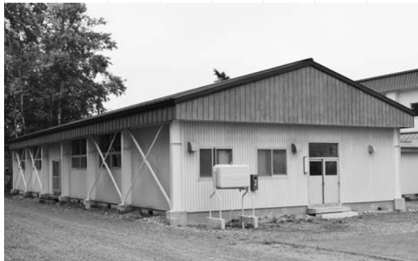
屋根の補修や外壁塗装が実施された格技場
