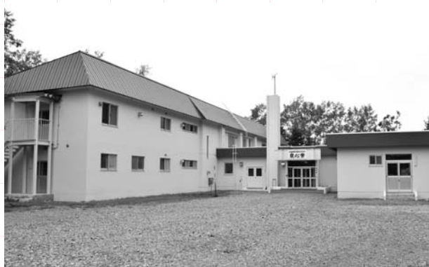
屋根の補修や外壁塗装が実施された寄宿舎
