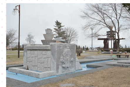
更別農村公園内の遊水路を改修し、安全性を高めます
