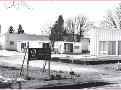
敷地内の舗装など外構工事を実施 地域創造複合施設整備事業 3,054万円
