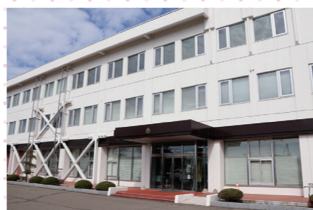
役場庁舎をはじめ公共施設に空調設備(エアコン)を設置します
