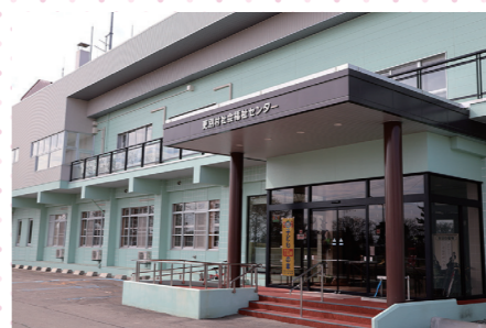
社会福祉センターなど公共施設で照明LED改修工事を行います
