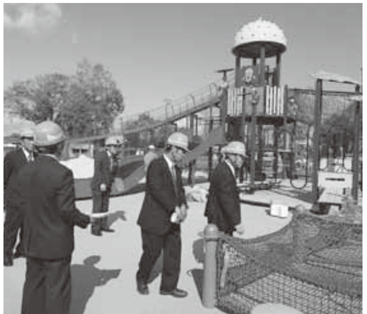
農村公園再整備の進捗状況を確認しました
